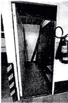
Ingreso a Bodega B
