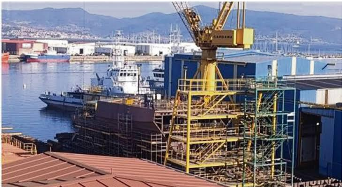
Una vista de la construcción de la OPV en el astillero español, antes de que fuera detenida.
