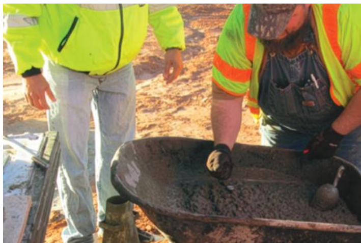
Fig. 2: Capacitación en el puesto de trabajo, donde un mentor enseña a una persona a realizar correctamente los ensayos de temperatura y revenimiento
