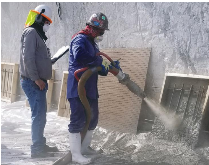
Los Inspectores de Concreto Lanzado del ACI ayudan a garantizar la calidad de la aplicación del concreto lanzado
