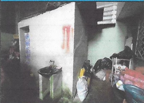
BAÑO EXTERIOR EN PATIO POSTERIOR.
