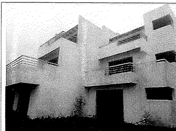
Lesly Moreno. (2024). Edificación Principal (suits y dormitorios).
