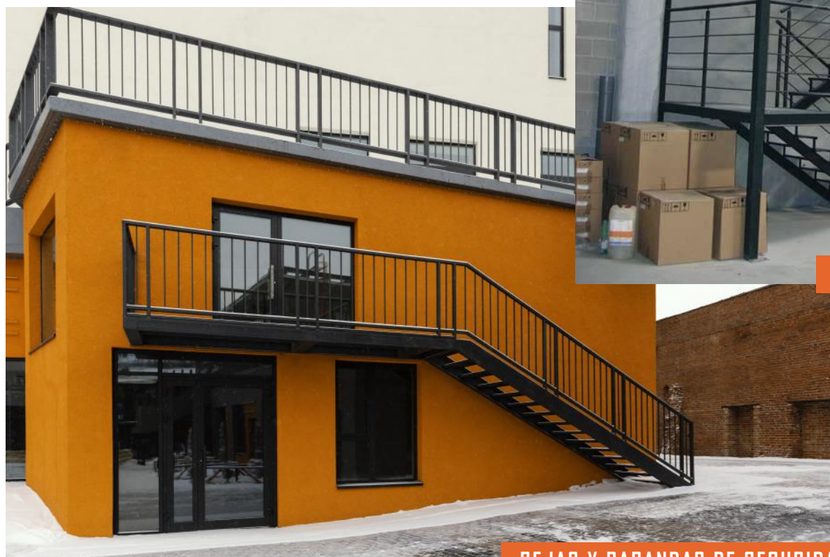
REJAS Y BARANDAS DE SEGURIDAD
