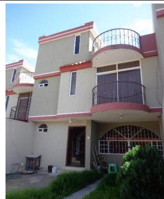
CASA 11. FACHADA INTERNA PRINCIPAL
