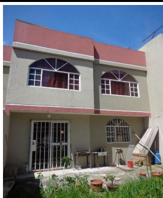
CASA 11. FACHADA POSTERIOR
