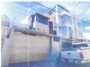
VISTA FRONTAL DE LA VIVIENDA
