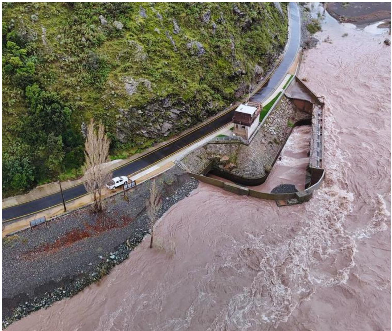
Foto aérea Bocatoma Armerillo, julio 2026.
