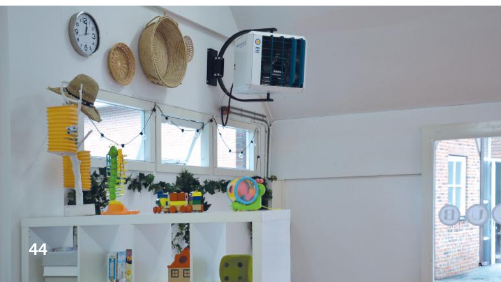
WCU circulatie unit voor verbeterde warmtespreiding
