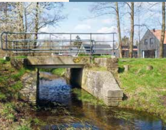
De vm. spoorbaan kruist de Koningsbeek, die o.a. de paleisvijvers van water voorziet
