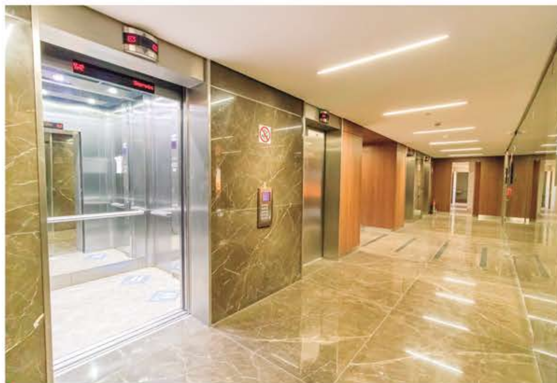
■ Além da manutenção, a escolha da empresa contratada merece o devido cuidado e atenção
