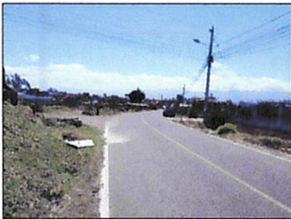
Vista de la calle Rocafuerte.
