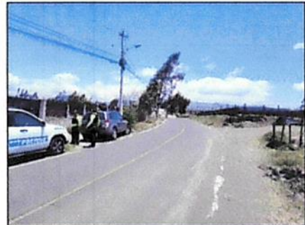
Vista de la calle Rocafuerte.
