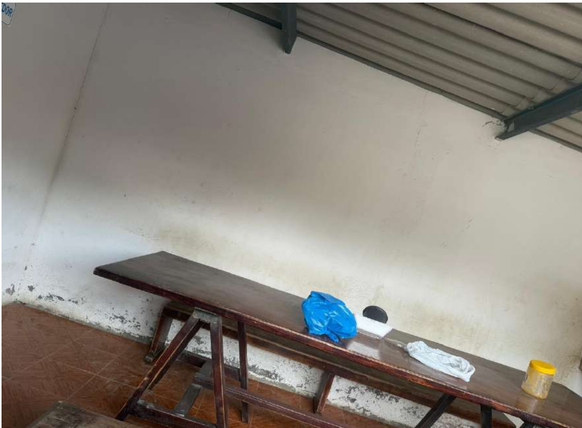
6. Fotografía interior de la construcción Mixta.
