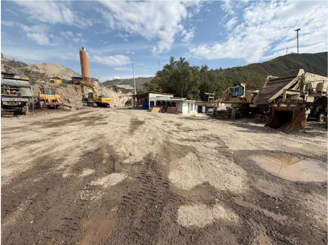
13. Fotografía del interior del bien inmueble.
