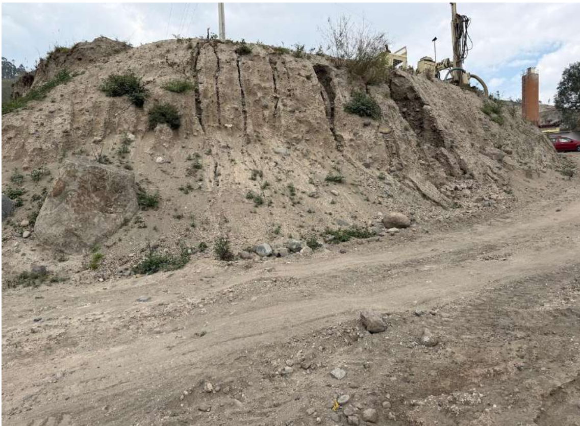
8. Fotografía del interior del bien inmueble.
