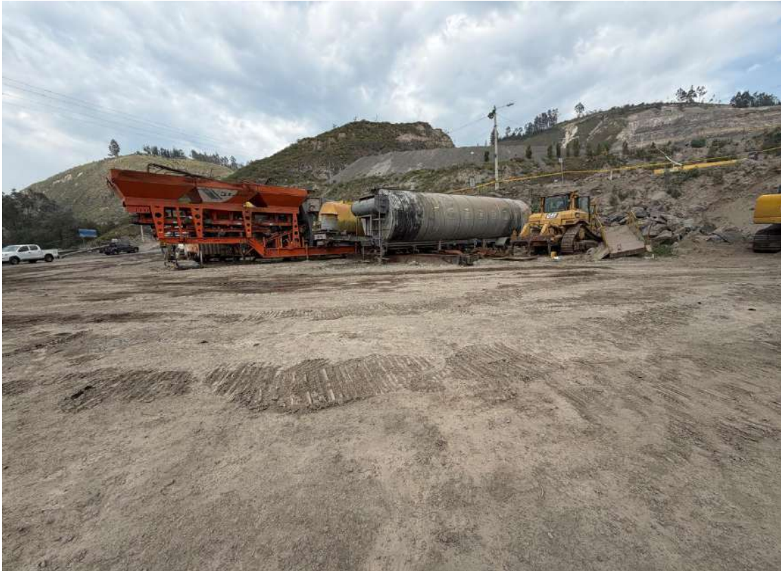
11. Fotografía del interior del bien inmueble.
