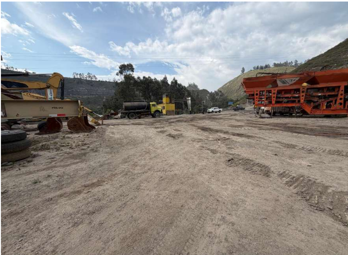
12. Fotografía del interior del bien inmueble.
