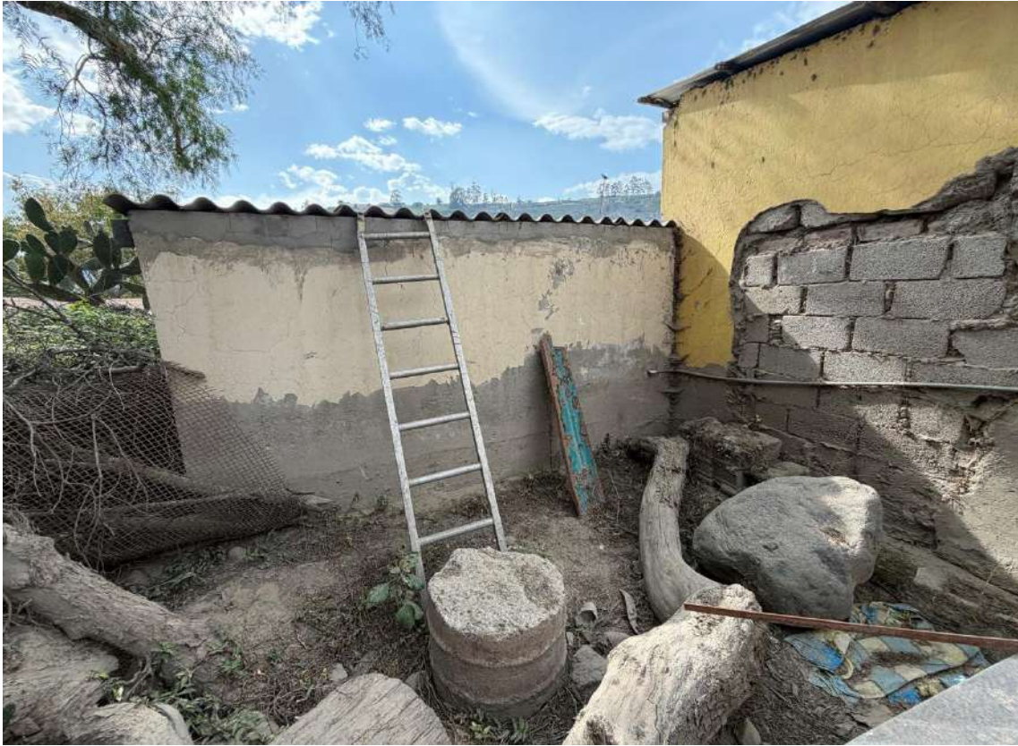
5. Fotografía posterior de la construcción Mixta.
