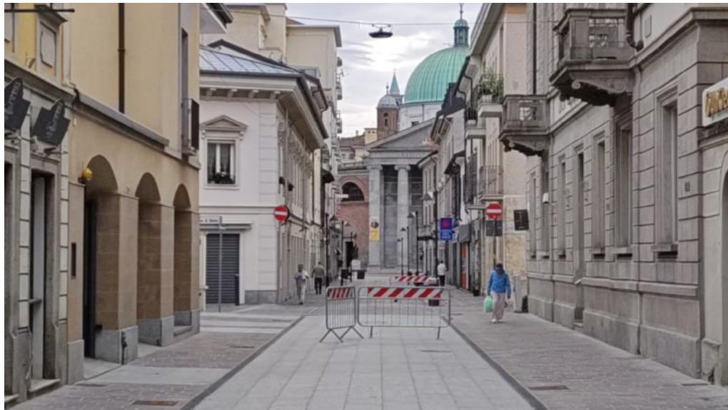
Il tratto già riqualificato di via Umberto I
