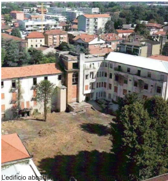
L'edificio abbattuto della clinica Santa Maria
