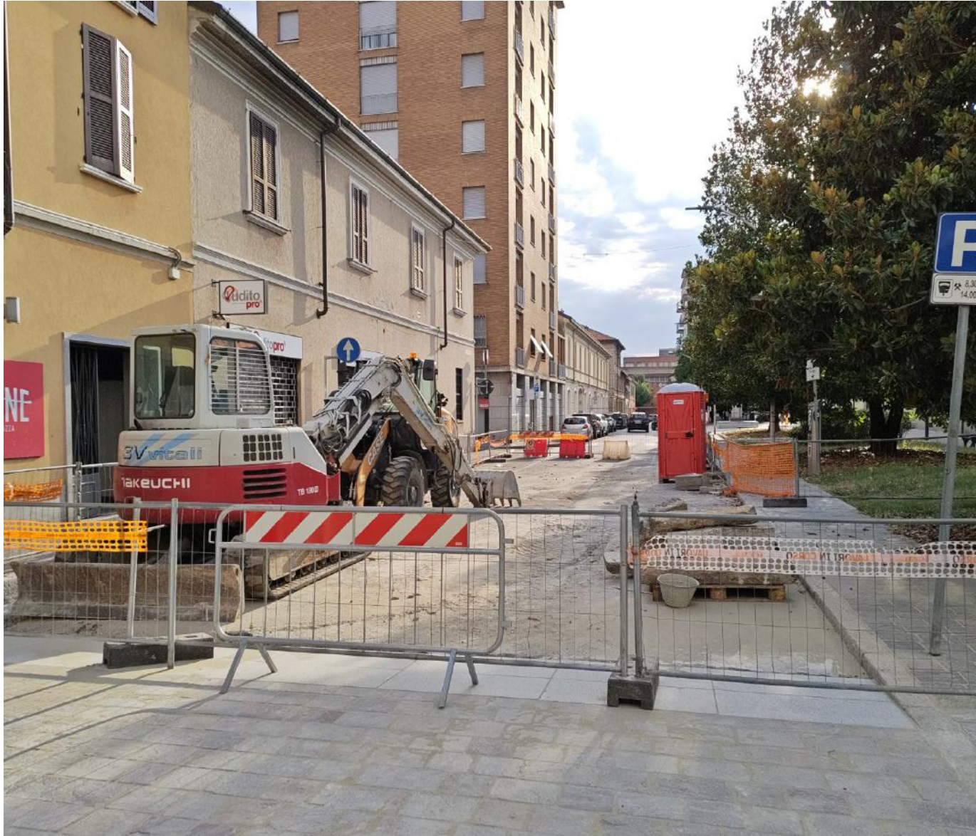
I lavori ancora in corso in via Umberto I
