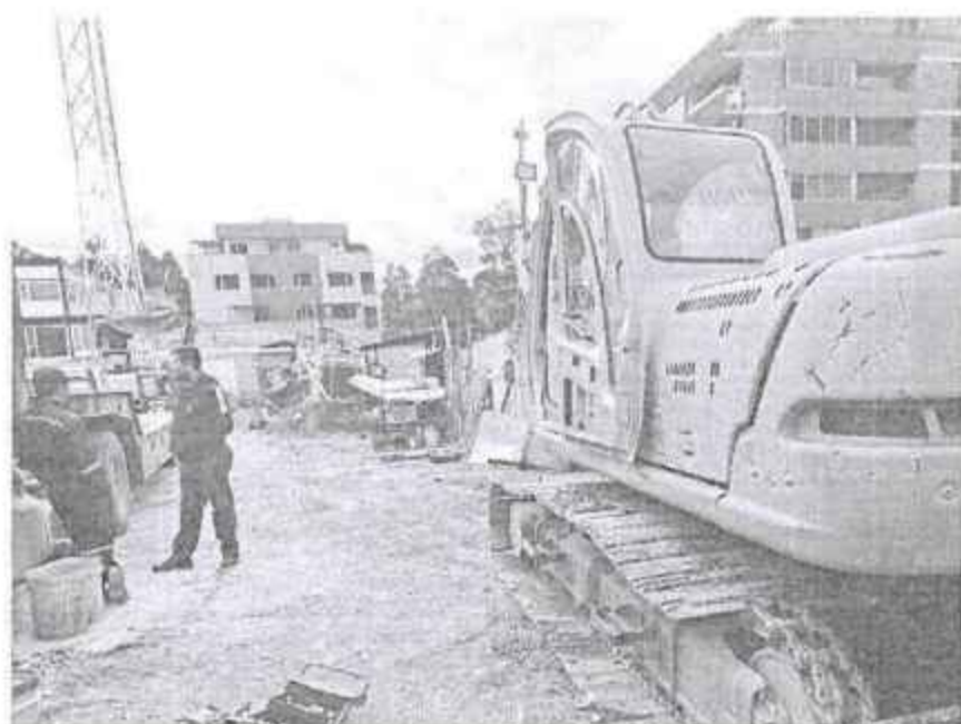
Figura 9 Estado del tren de rodaje zapatas faltantes
