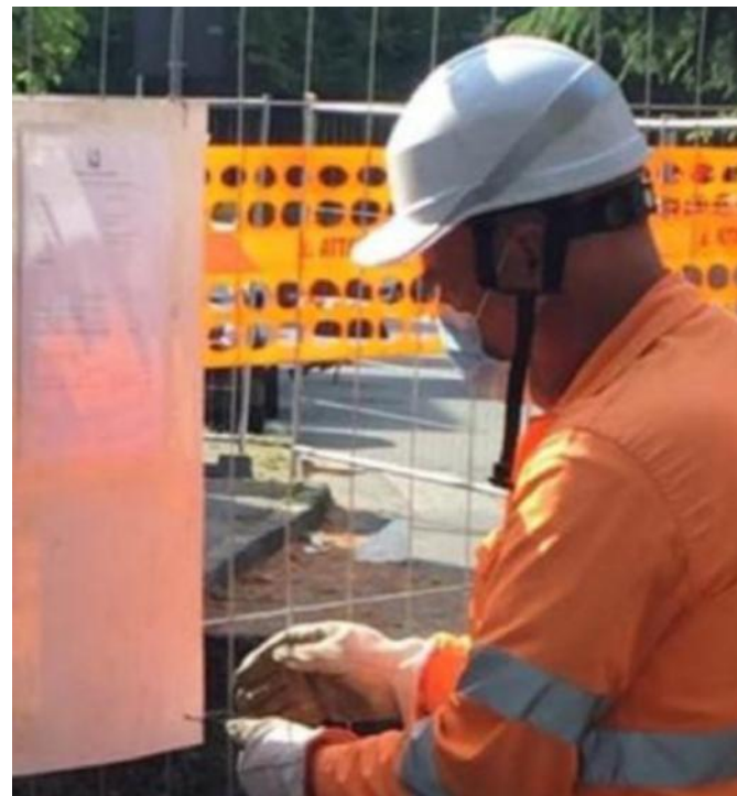
Saranno le maestranze di BrianzAcque ad eseguire l'intervento
