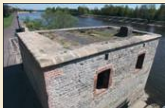
Der trutzige Rest des ehemaligen Eisenbahnfestungstors soll noch 2015 eröffnet werden
