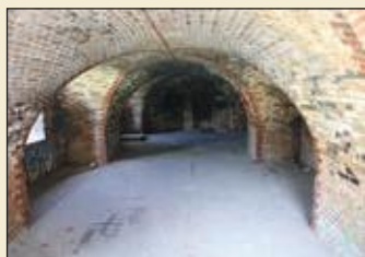
Das preussische Gewölbe gäbe einen schönen Rahmen für ein Restaurant
