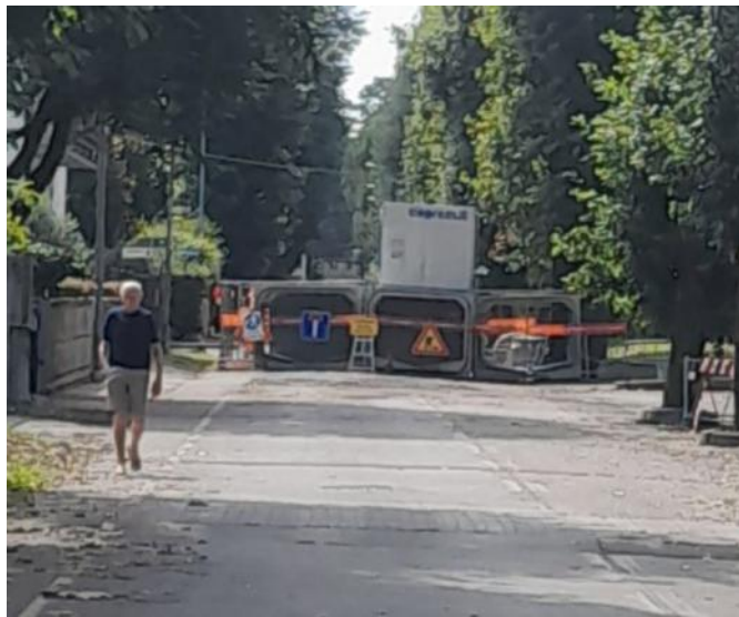
Il cantiere di via Parini
