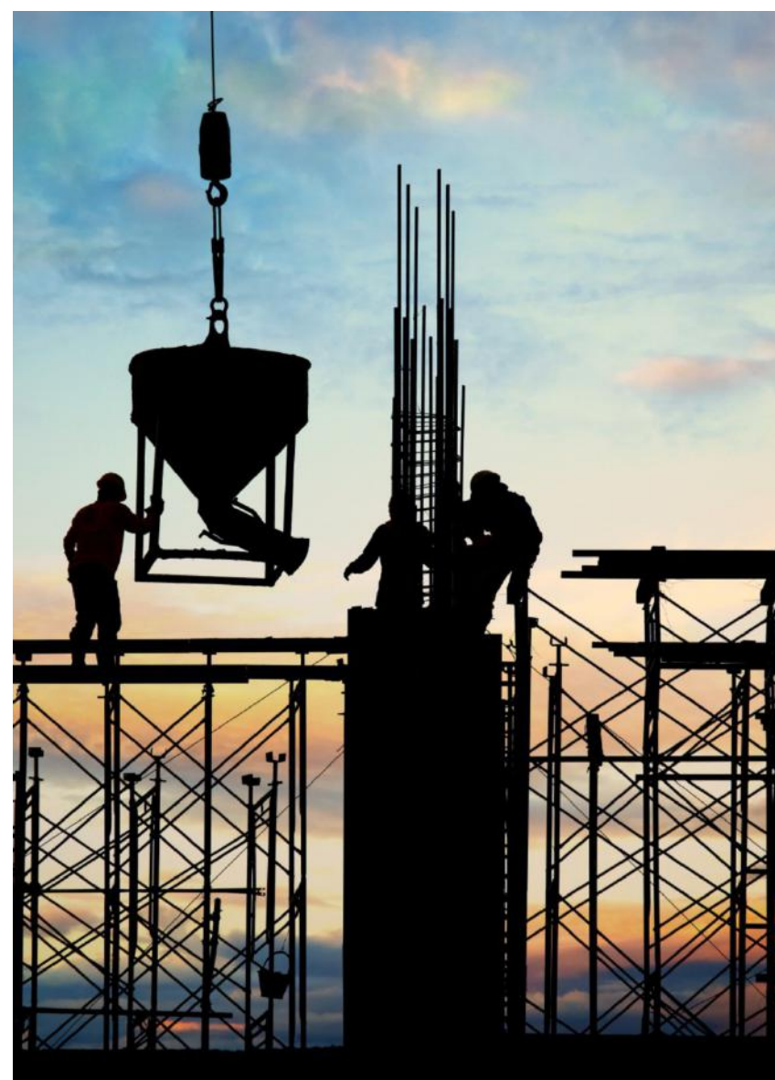
Un cantiere edile, con l'estate è allarme caldo per i lavoratori (immagine di jcomp su Magnific)
