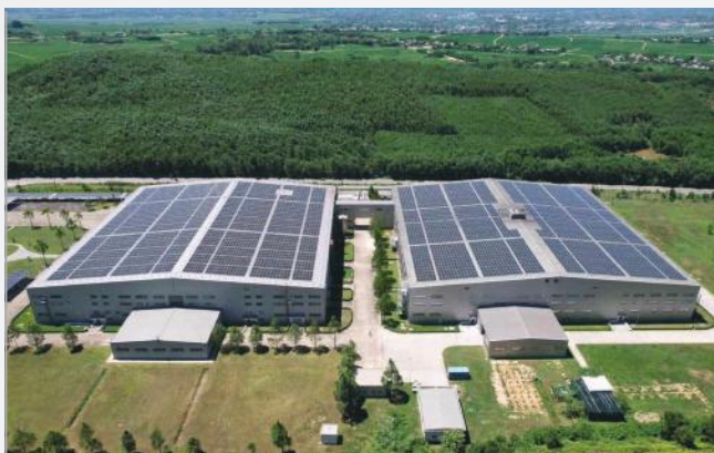
Nhà máy Groz - Beckert Factory
