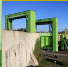
Das über 80 Jahre alte Schiffshebewerk Rothensee ist Teil des Wasserstraßenkreuzes zwischen Elbe und Mittellandkanal
