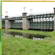
Das Pretziener Wehr ist Teil der Hochwasserschutzanlagen Magdeburgs und Wahrzeichen deutscher Ingenieurskunst
