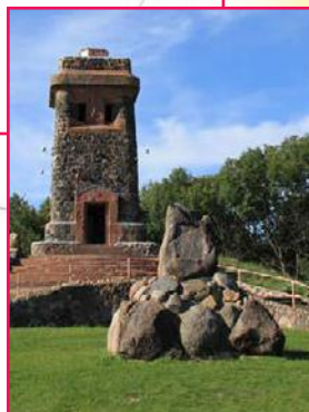
Der Bismarckturm auf dem Wartberg hebt sich 100 Meter über das Elbtal
