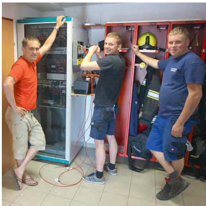
V.l.n.r.: Die Kameraden Haunschmied Gerhard, Affenzeller Josef und Freudenthaler Jakob bei der Montage der Brandmeldeanlage.
