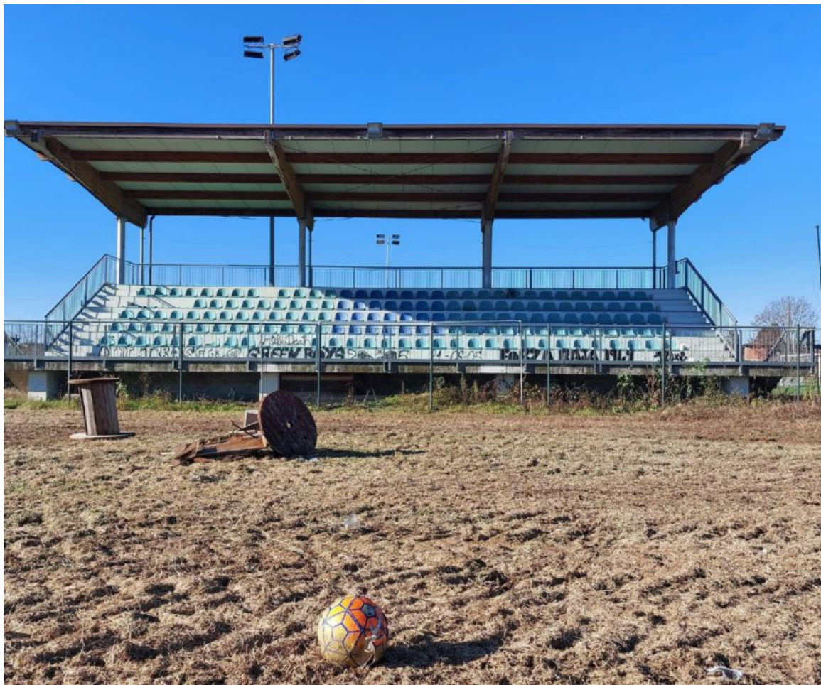
La tribuna del centro sportivo intitolato ad Aldo Boffi, attualmente oggetto di riqualificazione
