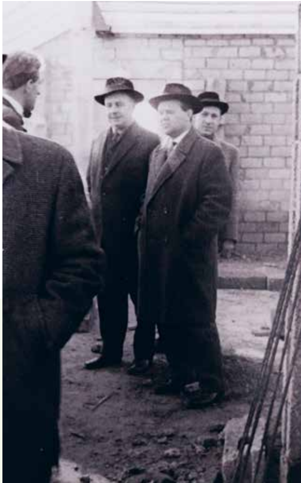
Baustellenbesichtigung durch Mitglieder des Aufsichtsrats der Selbsthilfe eG: Hans-Peter Massau, Paul Wagenblast und Werner Geiger (im Hintergrund)
