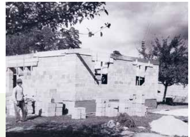
Zwischen 1949 und 1957 wurden von der Siedlungsgenossenschaft insgesamt 132 Häuser und 216 Wohnungen als Eigenheime errichtet. Hier die Baumaßnahme Am Schattwald 42-44
