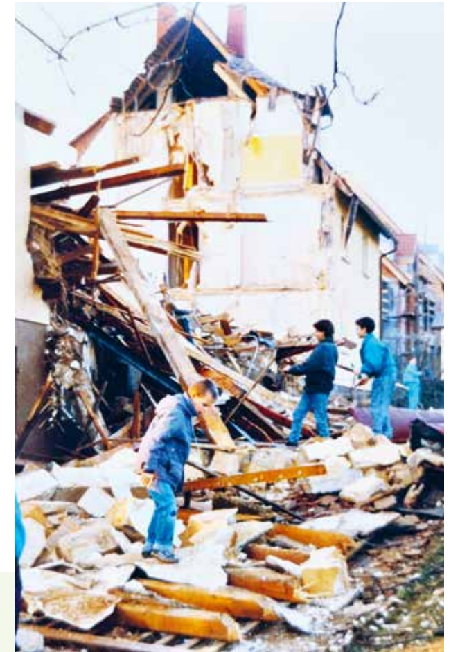
Die Bauruine als Abenteuerspielplatz - neugierige Kinder beobachten die Abrissarbeiten eines Hauses der Filderbaugenossenschaft und inspizieren den Bauschutt.
