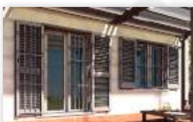
GRATE DI SICUREZZA
