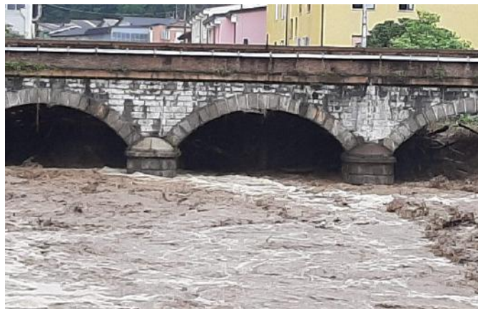
Il torrente Varrone oggetto di interventi per la messa in sicurezza
