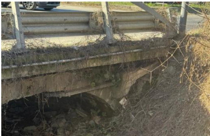
Lo stato di fatto del ponticello di Sala, sul torrente Carpine
