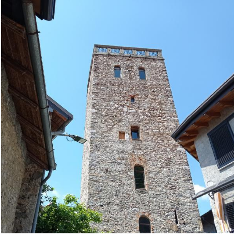
La Torre di Maggiana è chiusa a causa dei lavori di riqualificazione appena iniziati
