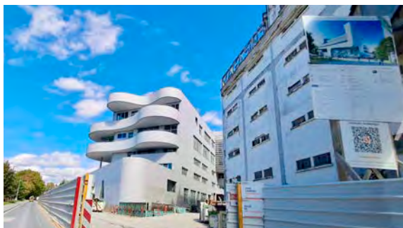
Les travaux du nouveau bâtiment de l'Ésad ne sont pas encore totalement achevés. © l'Hebdo du Vendredi
