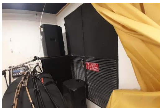
Vista Sótano - Cuarto Eléctrico
