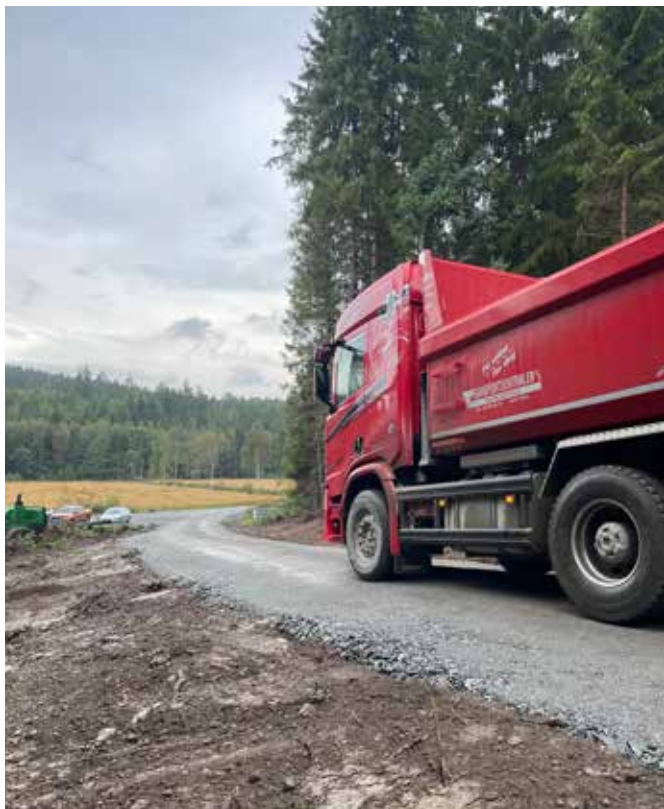
ANSTENDIGE ARBEIDSFORHOLD: Transport, bygg og anlegg og skogforvaltning er bransjer med risiko for brudd på arbeidstakerrettigheter, og Allstad forbedrer kontinuerlig innkjøpsrutiner, leverandørstyring og -kontroll. Her fra veiarbeid ved Hobøl prestegård. Foto: Allstad.
