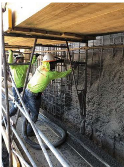
Fig. 4: Concreto lanzado por vía húmeda
