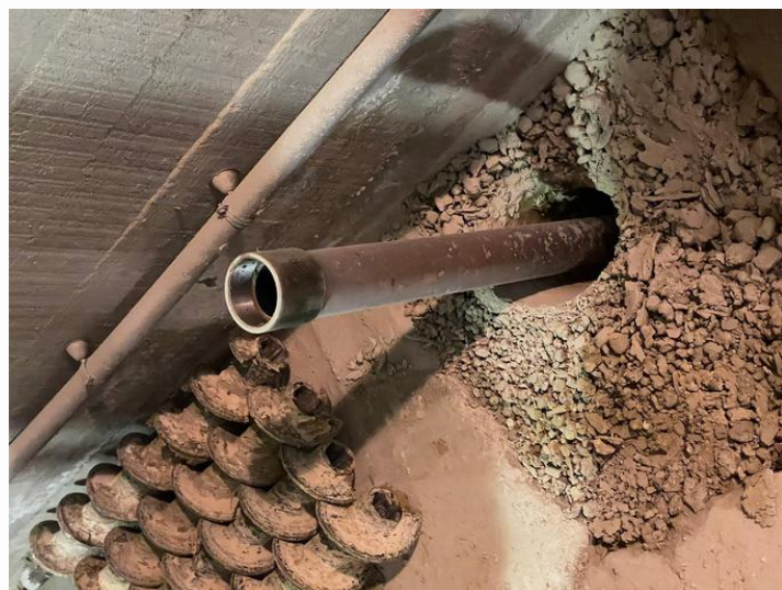
Pose de micropieux. Crédit photo : AccesSOL
