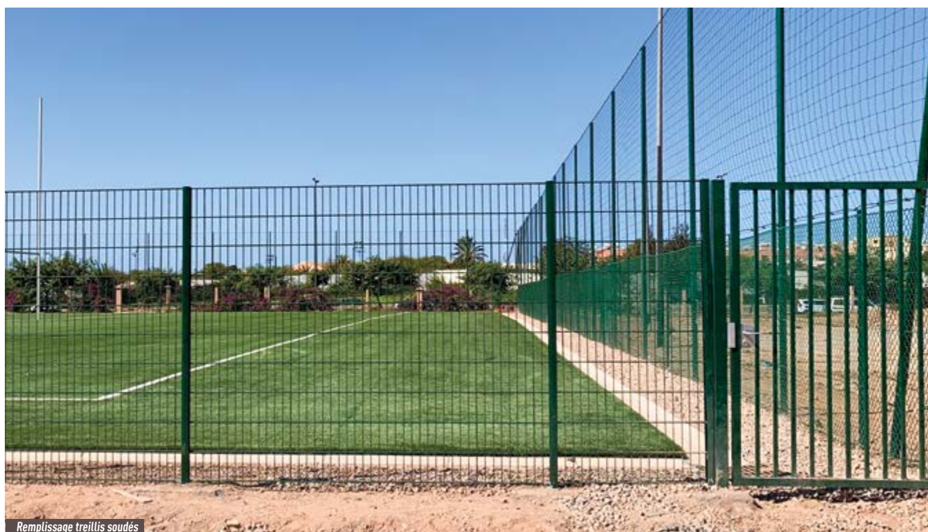
Remplissage treillis soudés
