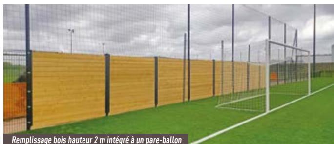
Remplissage bois hauteur 2 m intégré à un pare-ballon
