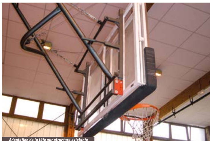
Adaptation de la tête sur structure existante
