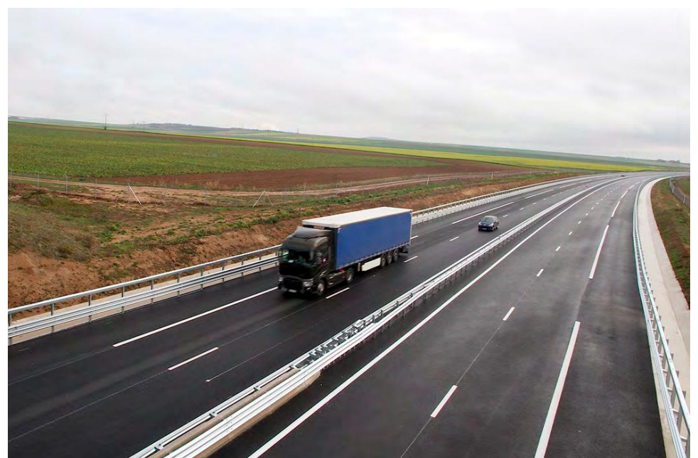
Deux chantiers d'envergure s'opéreront sur la RN44 jusqu'en mai 2027. © l'Hebdo du Vendredi
