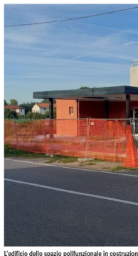
L'edificio dello spazio polifunzionale in costruzione
