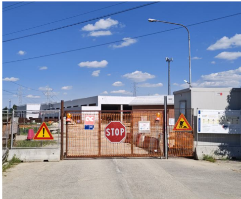
Il cantiere per la costruzione del deposito al confine con Desio
