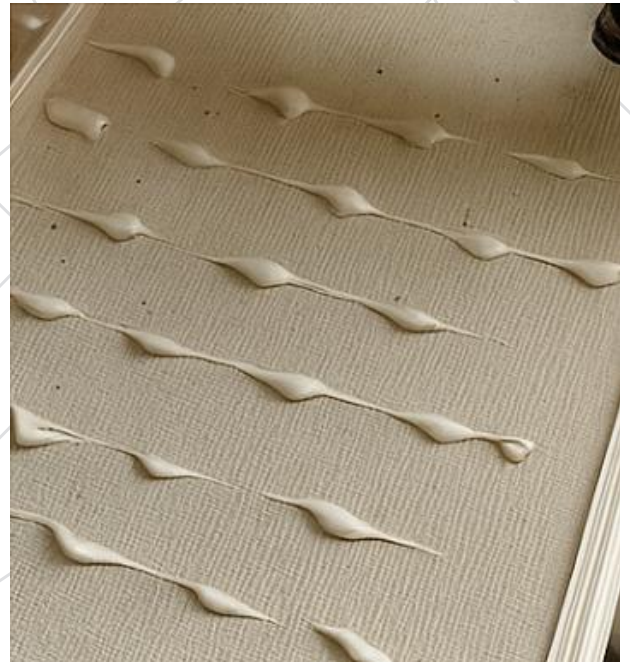
Aplica Pegamento en la base
