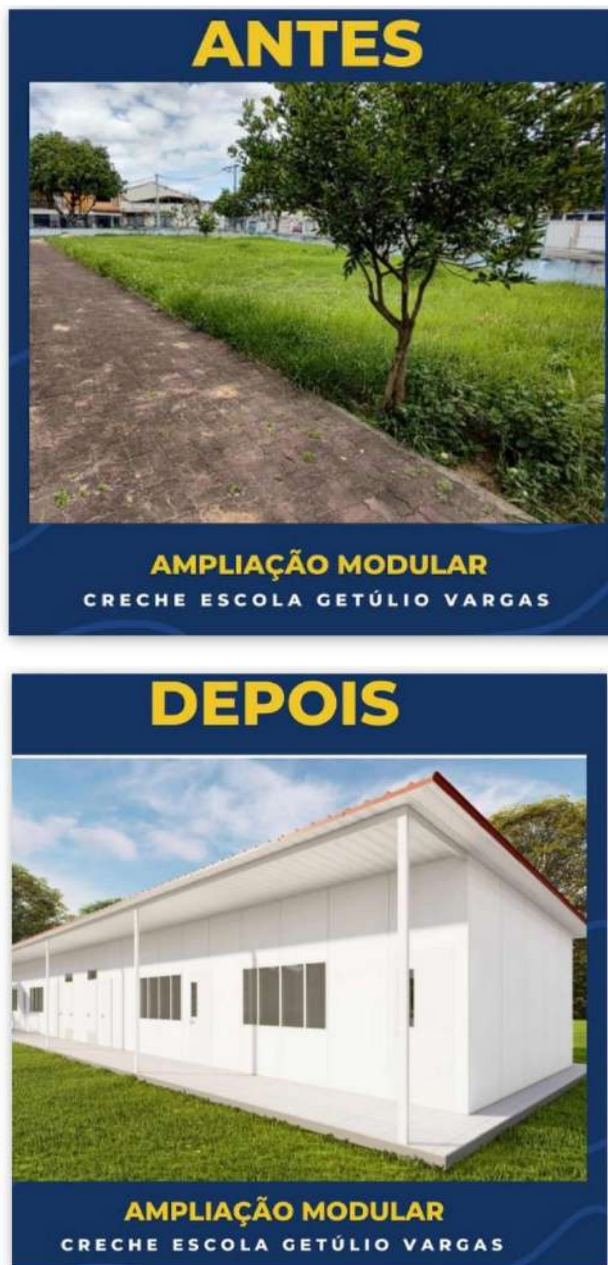
Figura 29: Antes e Depois da Creche Escola Municipal Getúlio Vargas
