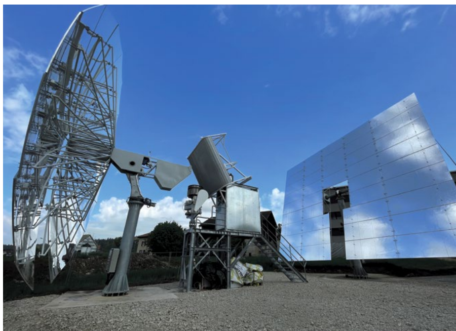
À droite, l'héliostat de 138 m 2 capte les rayons du soleil et les renvoie vers le concentrateur à gauche, qui concentre la lumière à la manière d'une loupe et la dirige vers un réacteur solaire placé en contrebas. Crédit photo PANATERE.
