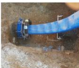
PRIMUS LINE SANACIJA
