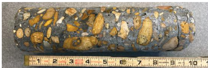
Fig 8: Núcleo de concreto extraído de la cara suroeste del pilar número 30
