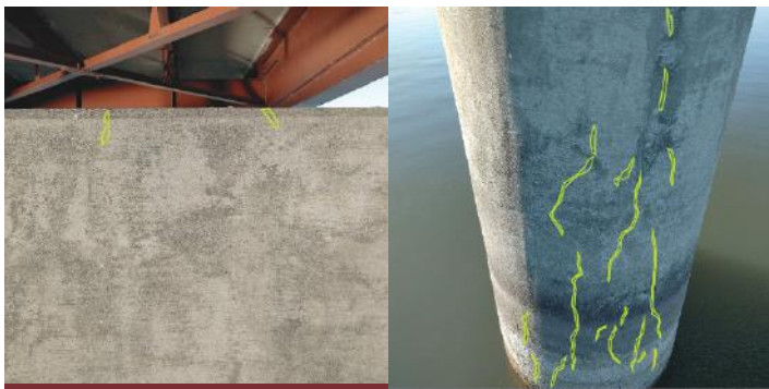
Fig. 4: Imágenes mejoradas del pilar 30 captadas por UAS.
