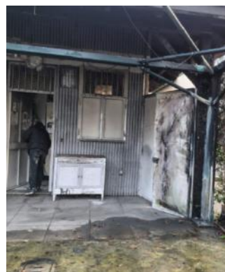
Il chiosco in attesa dei lavori
