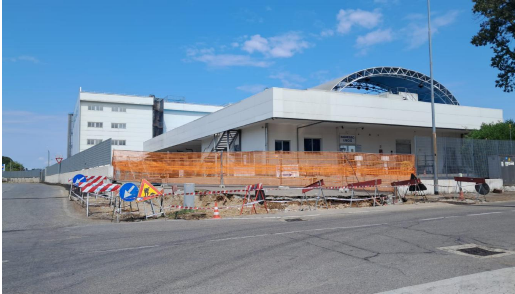
Il cantiere di fronte all'edificio dei Polaris Studios
