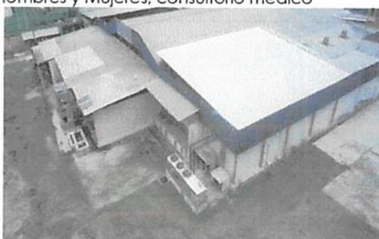
Vista general de la planta
