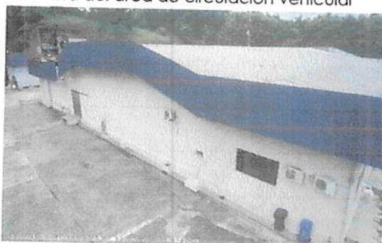
Vista exterior de los Galpones
