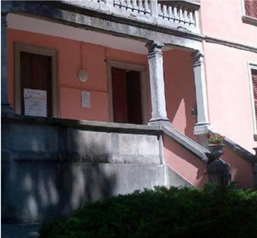
L'ingresso della sede della biblioteca comunale
