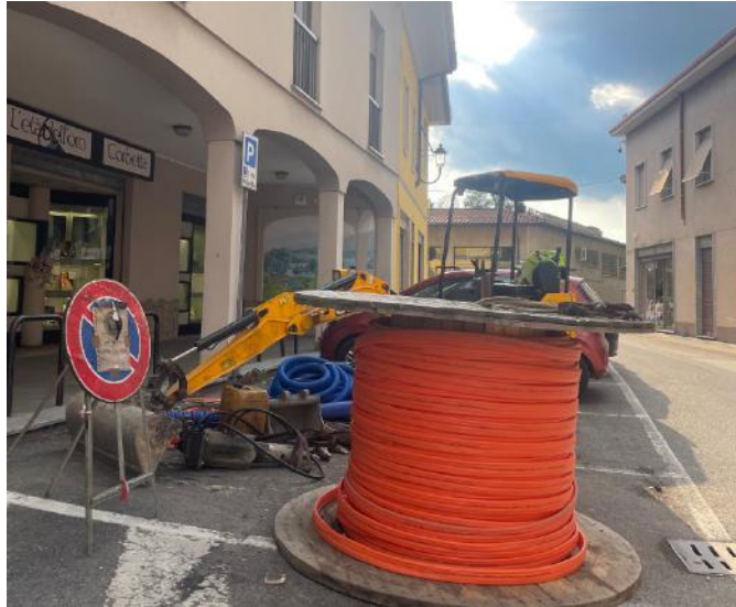
Strade sotto i ferri a causa dei lavori di ripristino di FiberCop
