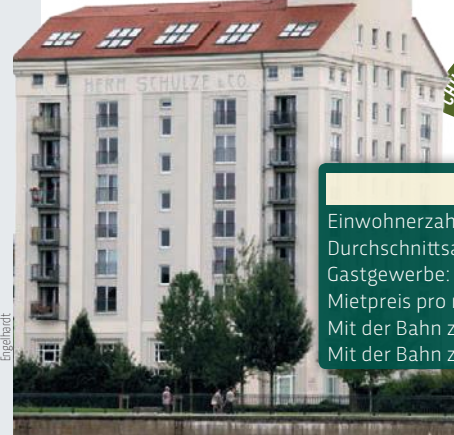
Stadtteilprägend: Der zum Wohnturm umgebaute ehemalige Getreidespeicher
