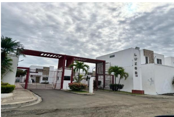
GARITA DE CONTROL DE INGRESO
