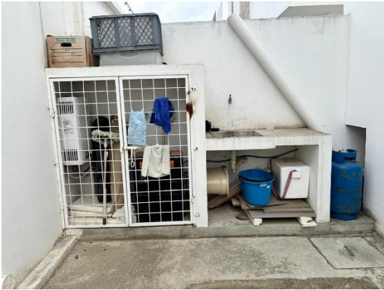
1.- CUARTO DE BOMBA 2.- MESÓN DE LAVANDERÍA
