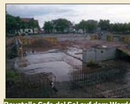
Baustelle Cafe del Sol auf dem Werder
