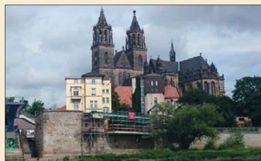
Blick von der Wasserseite auf die Baustelle am Eisenbahnfestungstor
