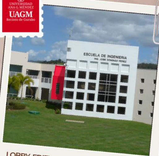
LOBBY, EDIFICIO DE INGENIERÍA JOSÉ DOMINGO PÉREZ UAGM — RECINTO DE GURABO
