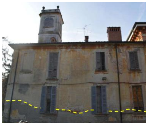
Altre immagini di parti degradate del complesso: un controsoffitto vicino al crollo e i problemi dell'umidità di risalita capillare
