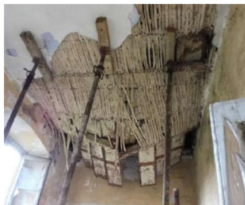
Altre immagini di parti degradate del complesso: un controsoffitto vicino al crollo e i problemi dell'umidità di risalita capillare
