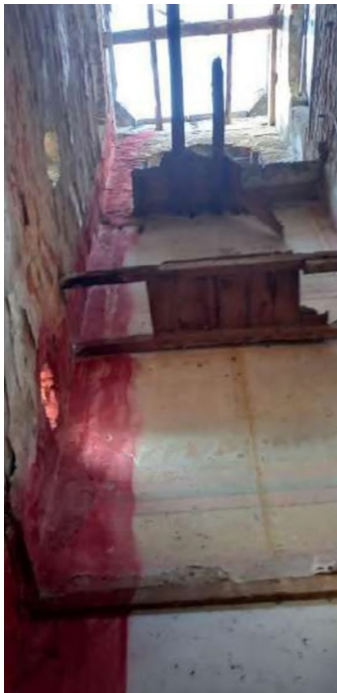
Altre immagini di parti degradate del complesso: un controsoffitto vicino al crollo e i problemi dell'umidità di risalita capillare
