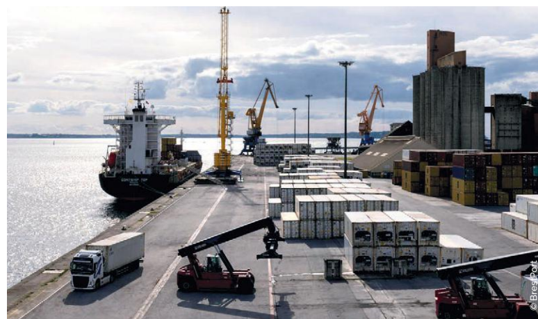
Le port dispose déjà de quatre grues mobiles, d'une passerelle roro (roll-on roll-off), de 600 mètres linéaires de quai et de 400 prises pour conteneurs réfrigérés
