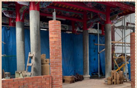
三川殿前圓柱是由弧形磚所砌築之圓柱。
