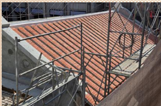
修復後的閩南瓦屋面仰合瓦。
