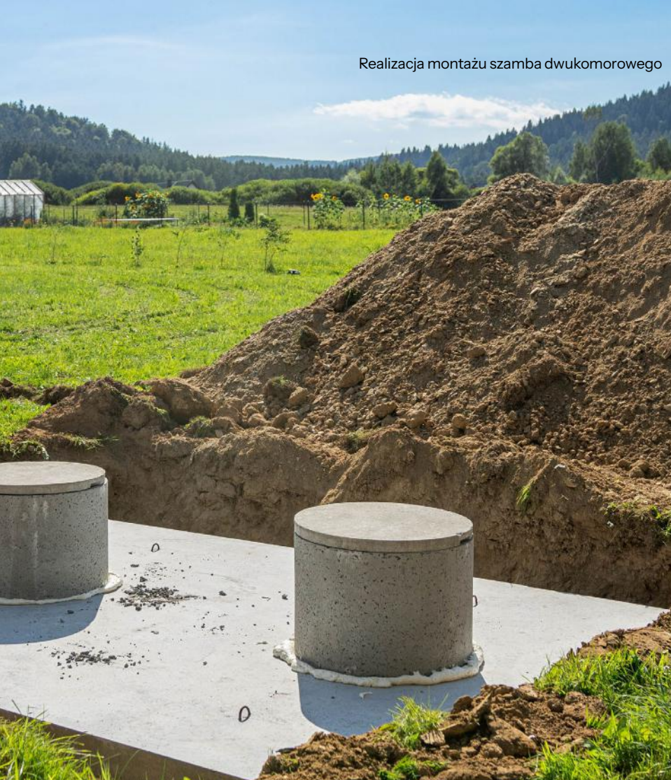
Realizacja montażu piwniczki Vinarium™ A1
